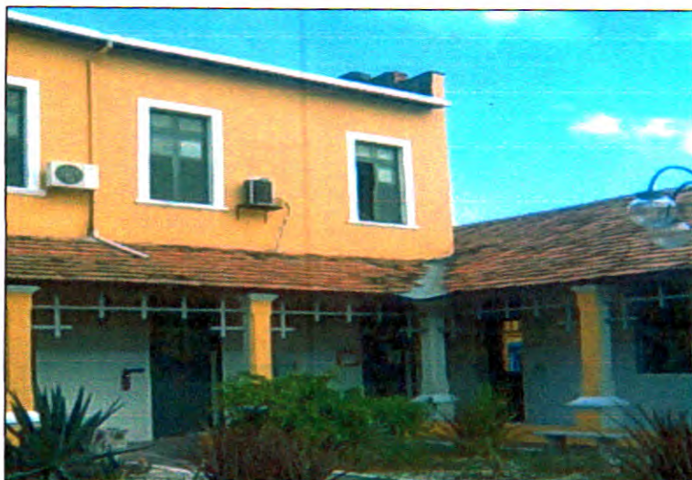
Figura 3 - Fachada externa do Pavilhão Antonio do Monte.
