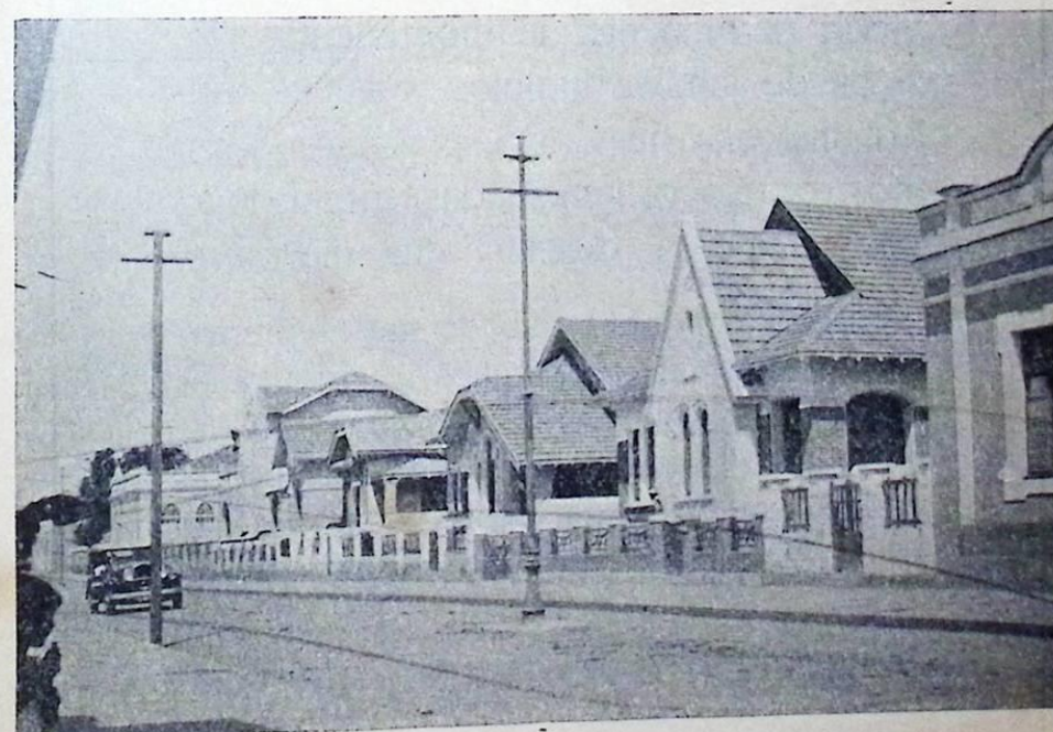
Belo conjunto de modernos bungalows, recentemente construídos á rua Dr. João Pessoa, arteria principal de Parnaíba
