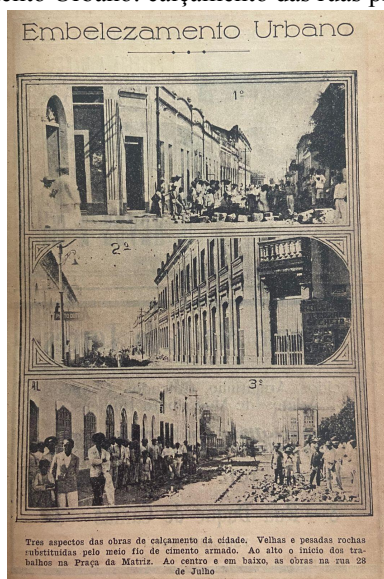
Figura 4 - Embelezamento Urbano: calçamento das ruas próximas à Praça Matriz.
