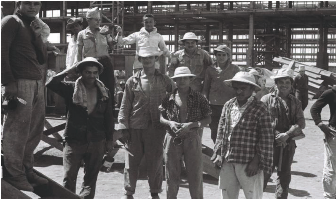
Imagem 06: Operários nas obras da Esplanada dos Ministerios-1957/1959 Fonte: Novacap 50 anos por Brasília – 2010.
