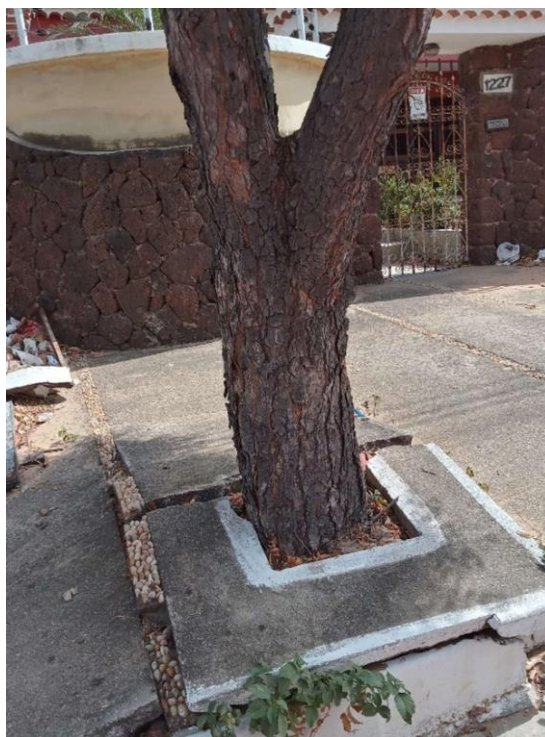
Apêndice 2. Prejuízo causado na calçada.
