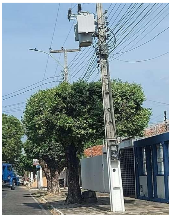
Apêndice 3. Impactos na fiação elétrica.
