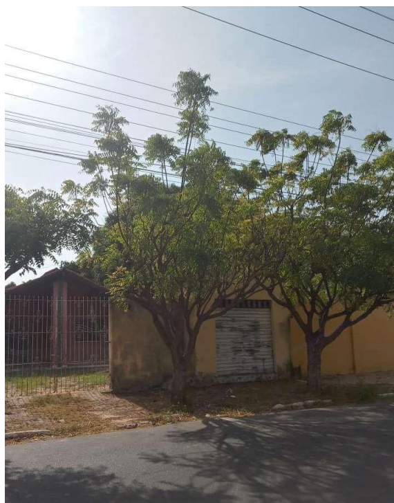
Apêndice 4. Impactos na fiação elétrica.
